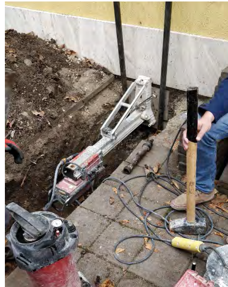
Figura 1. Secțiune în cadrul unui sistem de depresurizare pardoseală sau placa de beton a fundației.
