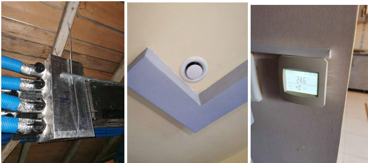
Figura 3. Secțiune în cadrul unui sistem de ventilație centralizat cu recuperare de căldură.
